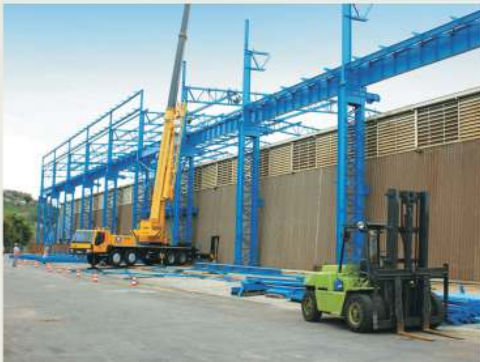
Montagem do galpão da Emalto Indústria Mecânica
