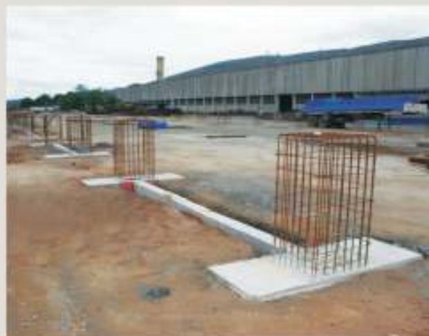
Fundação do galpão da Emalto Estruturas Metálicas
